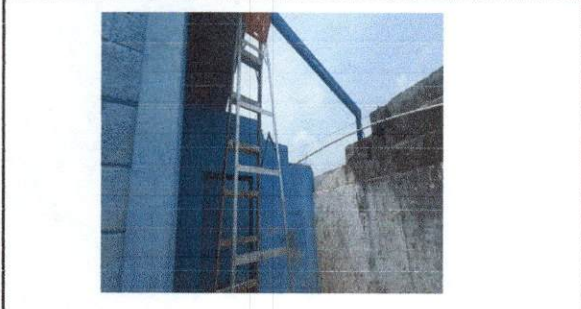
Foto 7: Trabajando en el cambio de techo en el baño de hombres
